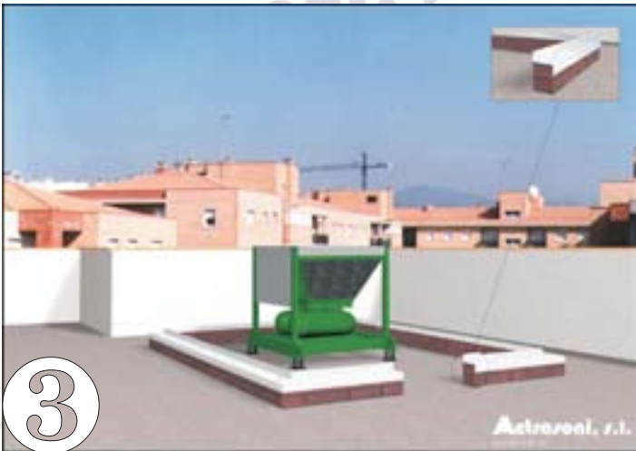
Colocación de un perfil en forma de "Z" para evitar la entrada de agua en el encapsulado. Atornillado sobre el zunchos de nivelación.
