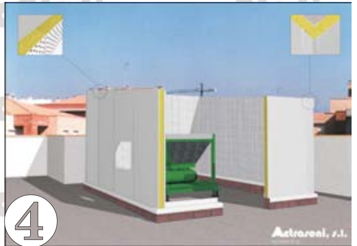
Colocación de paneles de junta integrada ( machimbrados ) y con chapa perforada por la cara interior de la cabina.
