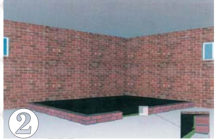
Colocación de dos capas de material antivibratorio A-1 seguido de una capa de material aislante PKB2
