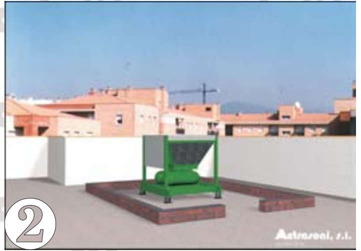
Designación del perímetro y levantamiento de un zunchos de nivelación sobre el que se construirá la cabina.
